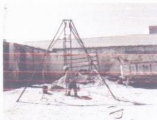
Figura 5: Registro da execução da sondagem à percussão (SP-02) no município de Teixeira - PB.
