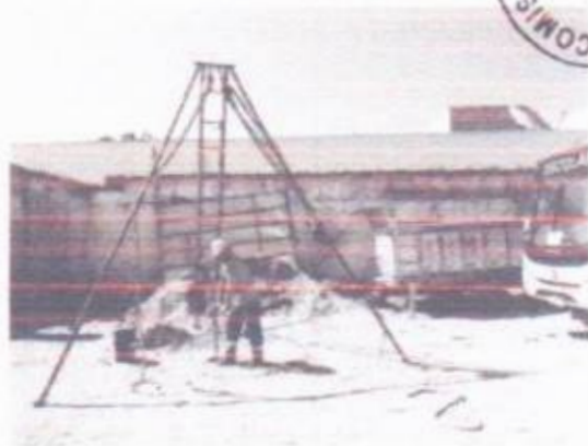
Figura 4: Registro da execução da sondagem à percussão (SP-02) no município de Teixeira - PB.
